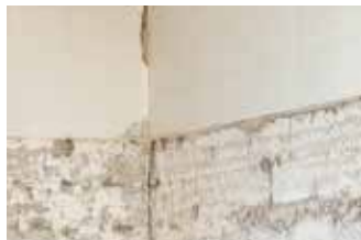
Verwijder plinten en pleisterwerk
