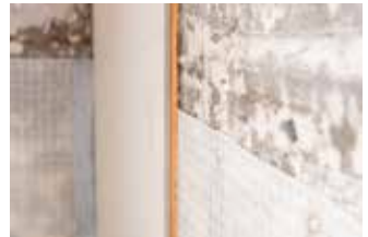
De plaat op zijn plaats zetten en goed aandrukken
