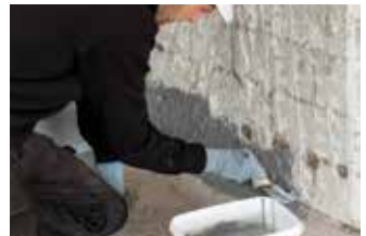
Werk tot +/- 5cm boven de boorgaten
