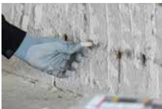
Duw de Stick tot 0,5cm voorbij het muuroppervlak
