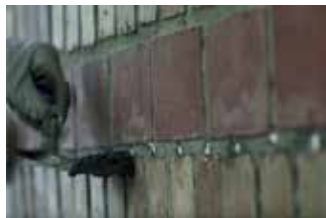
Dicht de gaten met mortel of DryStone Cement
