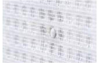
Het membraan tussen 2 pluggen steeds strak trekken
