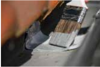
1 e laag aanbrengen en 3u laten drogen
