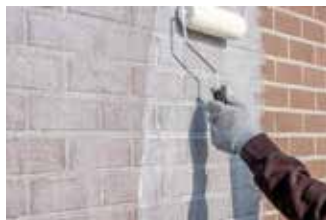
Werk in dambordpatroon (vakken van max. 1m 2 )
