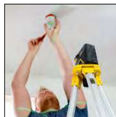
Loodlijn - neem een punt van vloer tot plafond
