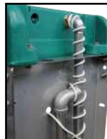
Variante heizbar, Anschluss an Ringleitung mit Frostschutz-Heizleitung am Ventil
